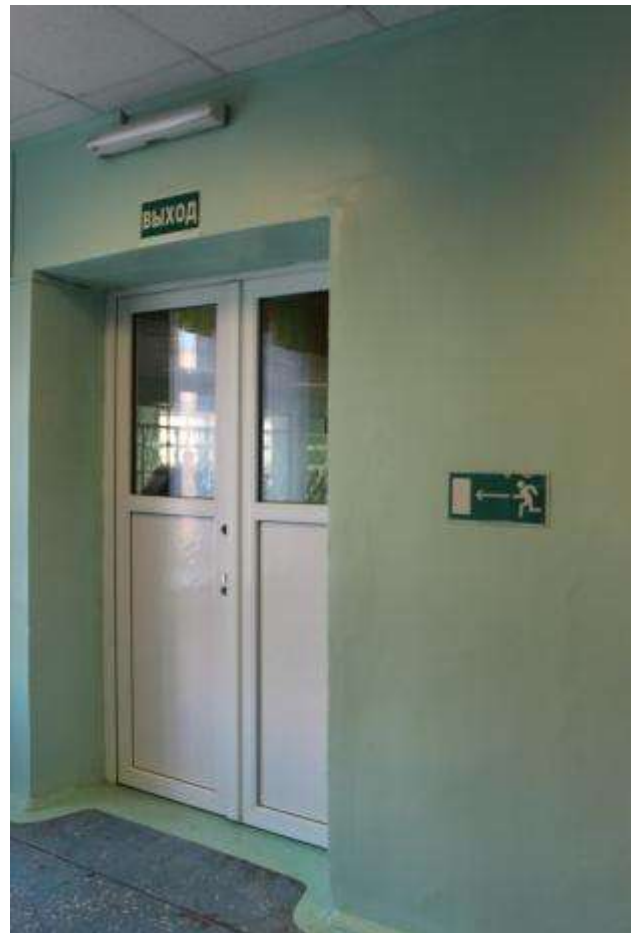
Фото 3.11. Пути эвакуации (в т. ч. зоны безопасности)
